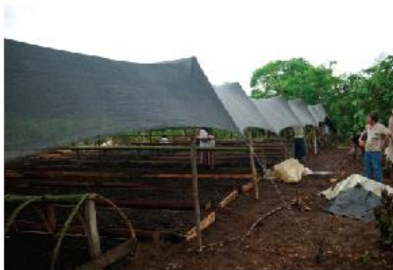
Construcción de cobertizo
